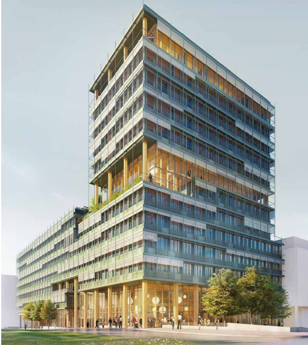
Bayerns höchstes Holzhybridhaus: Das „UmweltHaus“ in Nürnberg beweist mit 52 Meter Höhe und 13 Vollgeschossen die Tragkraft der BauBuche, besonders in den unteren und mittleren Geschossen (Blick unten auf die Stützen und die Träger aus den verklebten Buchenholzschnitten). Wo weiter oben die Lasten abnehmen, wurde auch die übliche Fichte eingesetzt. Entscheidend war die Vorfertigung der meisten Bauteile.
