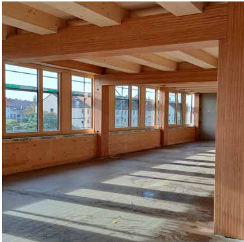
Bayerns höchstes Holzhybridhaus: Das „UmweltHaus“ in Nürnberg beweist mit 52 Meter Höhe und 13 Vollgeschossen die Tragkraft der BauBuche, besonders in den unteren und mittleren Geschossen (Blick unten auf die Stützen und die Träger aus den verklebten Buchenholzschnitten). Wo weiter oben die Lasten abnehmen, wurde auch die übliche Fichte eingesetzt. Entscheidend war die Vorfertigung der meisten Bauteile.
